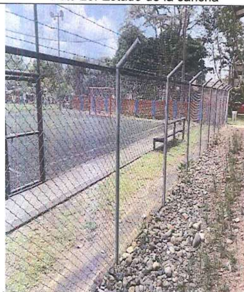
Foto 27. Cerramiento en malla eslabonada
